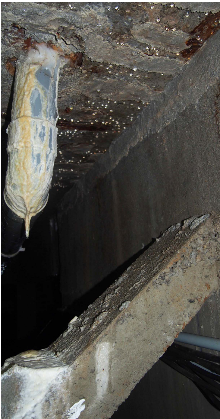
Vestiges des anciens réseaux en grès Réseaux PVC issus des travaux de 2010, avec joint silicone apparent
