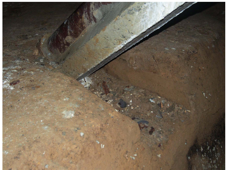
Vestiges des anciens réseaux en grès Réseaux PVC issus des travaux de 2010, avec joint silicone apparent
